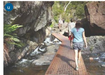
Passadiço: esta estrutura leve deverá ser construída para auxiliar o caminhar dos visitantes sobre as pedras da margem do Salto do Yucumã, cujo acesso, mobilidade e acessibilidade atualmente são problemáticos. A estrutura metálica ficará levemente elevada e sobreposta às pedras durante a seca.
