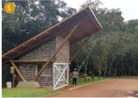
Pórtico de acesso/ Guarita de controle: esta estrutura de recebimento dos visitantes e de controle de acesso está em bom estado de conservação e só requer manutenção constante de seu madeiramento, instalações e revestimento.
