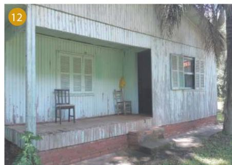
**Casa Funcional/ vigilância:** a casa com estilo típico da região e revestimento e estrutura de madeira, deverá ser inteiramente reformada, inclusive em sua parte elétrica e hidráulica, para receber serviços de apoio à visitação no núcleo.
