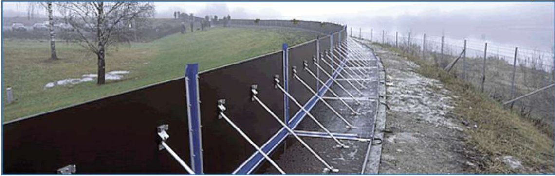
Figura 8 – Dique Aquafence montada em margem de rio
