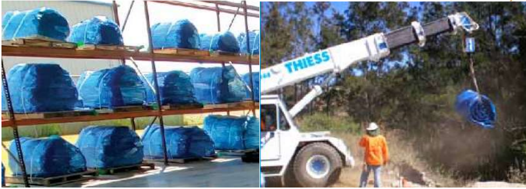
Figura 25 – Armazenamento dos rolos Aquabarrier em prateleiras e posicionamento mecânico
