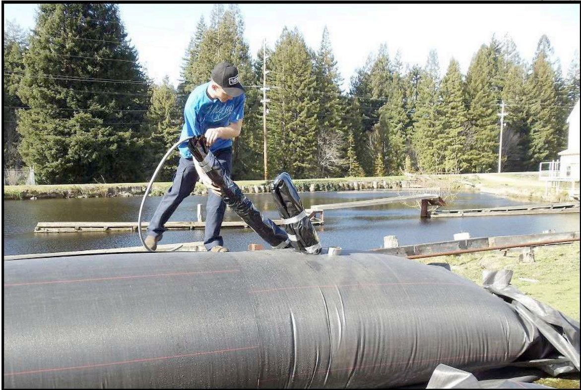
Figura 16 – Foto mostrando conexão entre barragens Aquadam, com destaque para os “fill tubes”
