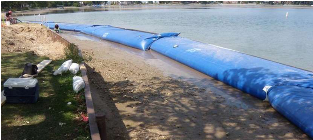
Figura 6 – Barragem inflável com água da AquabARRIER aplicada como dique
