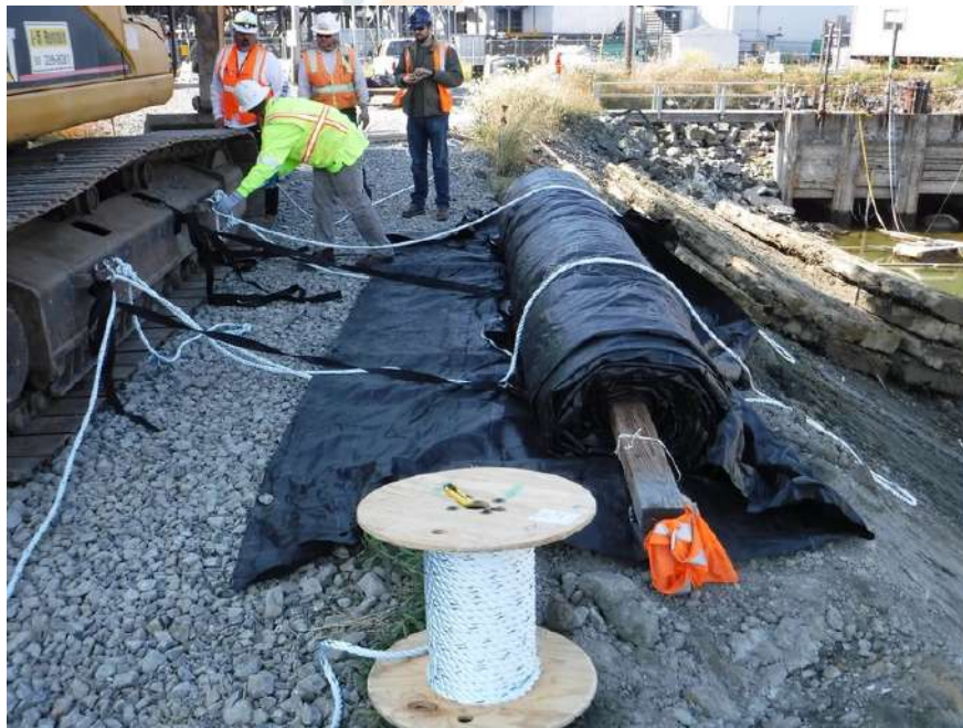
Figura 23 – Rolo de Aquadam sendo aprontado para desenrolagem
