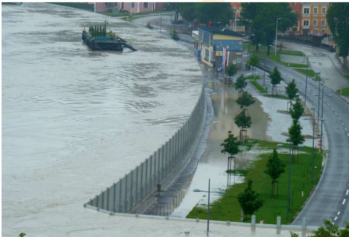
Figura 12 – Dique da IBS montado em Grein, Áustria, 2013 ( www.hochwasserschutz.de )
