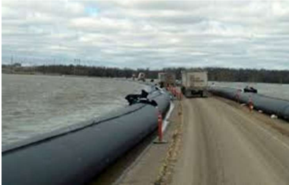
Figura 4 – Barragem inflável com água da Aquadam aplicada como dique
