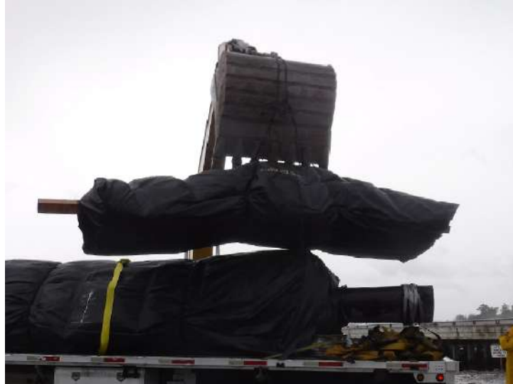
Figura 22 – Retirada ou carga do rolo da Aquadam de uma carreta com retroescavadeira
