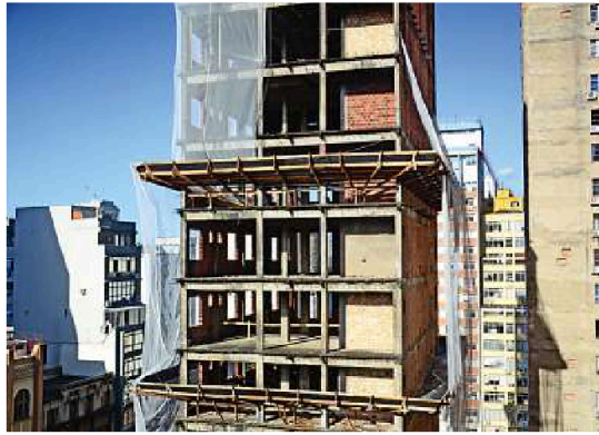
Demolição foi embargada por falta de segurança para os trabalhadores
