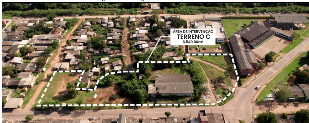
Figura 13. Imagem Aérea do Terreno C.
