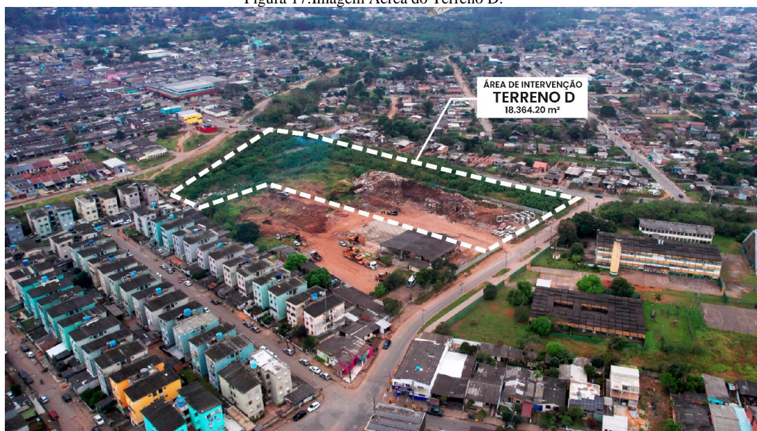
Figura 17: Imagem Aérea do Terreno D.
