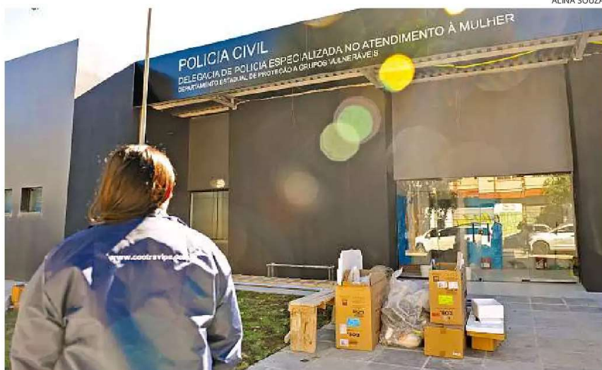
Estrutura está sendo preparada para abrigar os plantonistas nos períodos diurno e noturno
